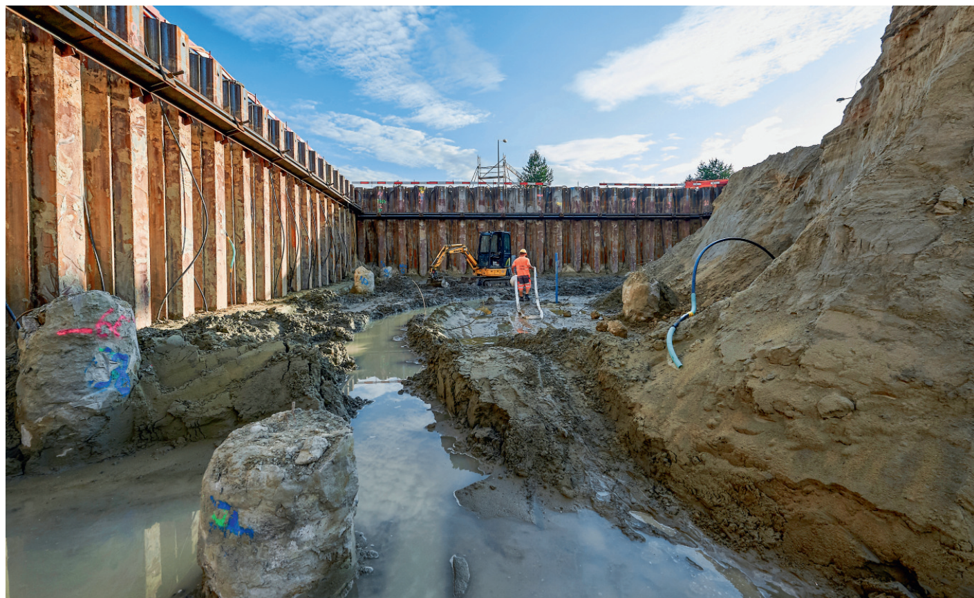
Après la démolition des anciens arsenaux, le sol a été dépollué. Les fouilles ont nécessité une enceinte de palplanches complète avec pompage continu, car la nappe n'est qu'à un mètre de profondeur. L'édifice est fondé sur 109 pieux ferrailés de 30 mètres.
