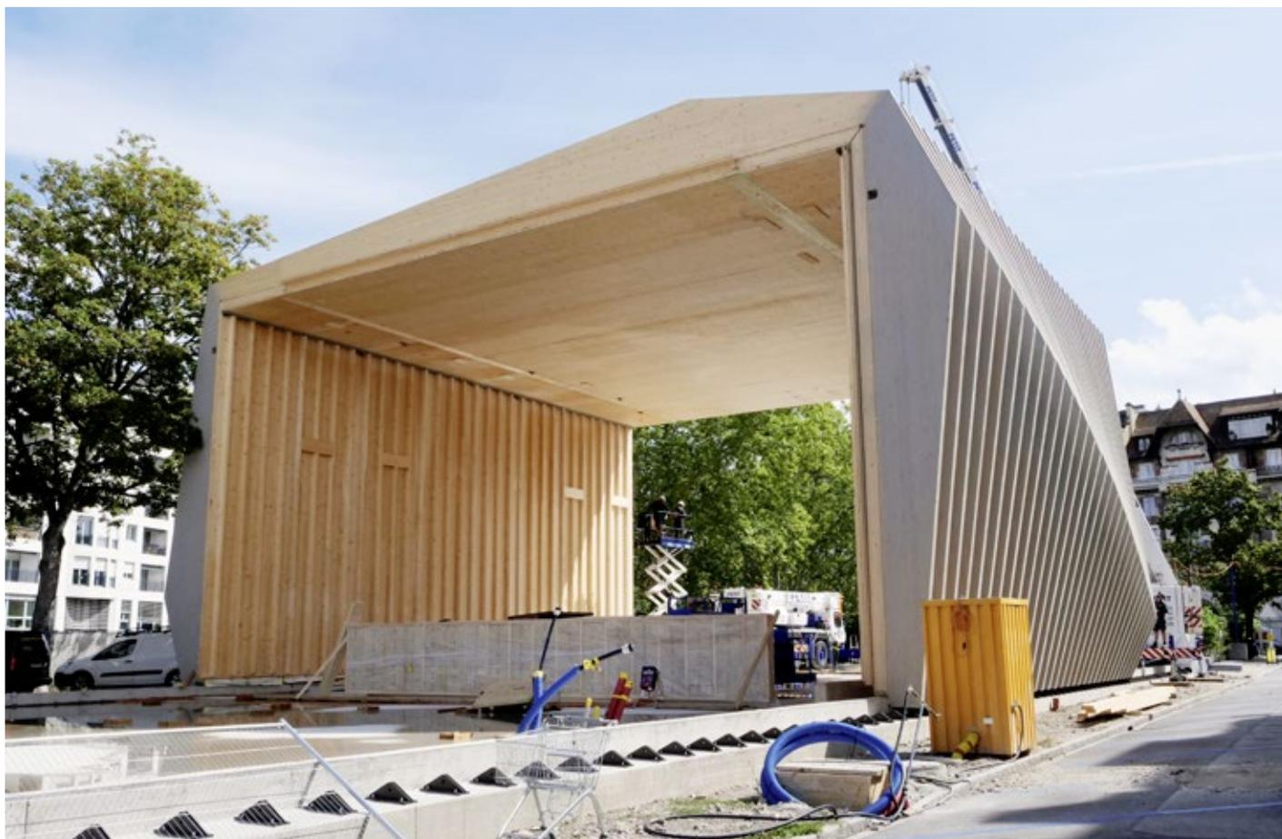
La structure rectangulaire de 51 m sur 20 m et 11 m de haut se décompose en 85 portiques différents dont les découpes se suivent d'un élément à l'autre.
