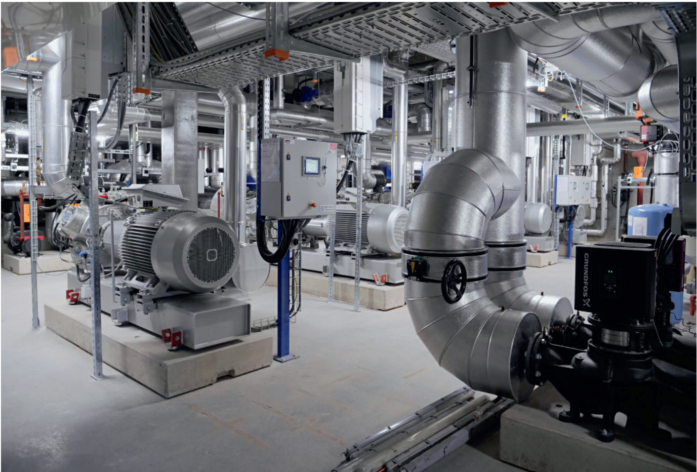
Pour fabriquer de la glace, on dégage de la chaleur qui est récupérée pour les bassins. Pompes à chaleur et machines réfrigérantes se cachent dans les entrailles du complexe pour permettre ce jeu de vases communicants.
