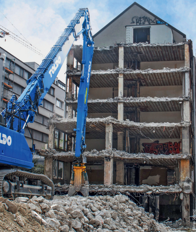
Les infrastructures hôtelières ont les faveurs des investisseurs. A Zurich, l'Hôtel Continental sera remplacé par un nouveau complexe ultramoderne. Les travaux de démantèlement battent actuellement leur plein.
