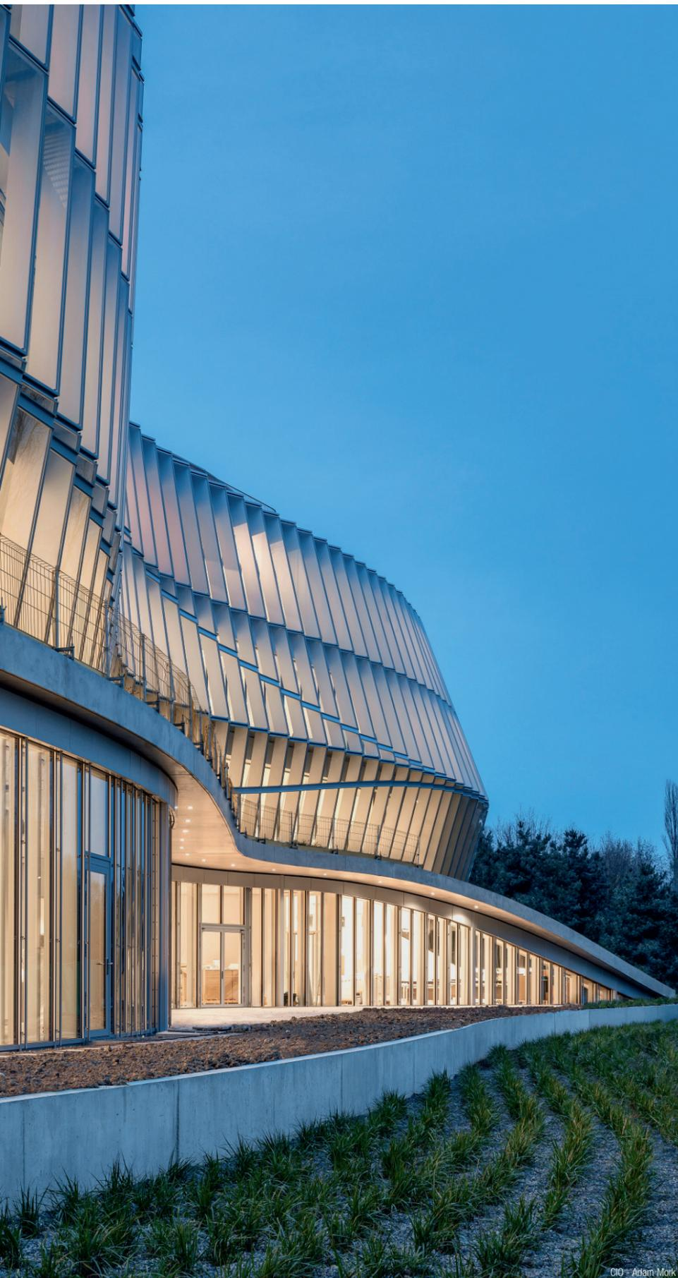
Pour imprimer à la façade ses mouvements dynamiques et ondulés, le pourtour du bâtiment est construit sur une structure métallique composée de 200 piliers par étage. Leur inclinaison varie de 0 à 30 degrés par rapport à la verticale avec une géométrie unique pour chaque pilier.
